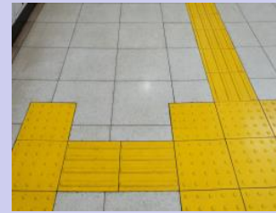
視覚障害者誘導用ブロック
