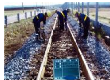
レールの修繕
